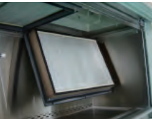
②HEPAフィルターの固定ボルトを外して、フィルター交換
