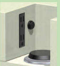
▲測定孔&コンセント
